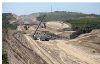
Tăierea versanților pentru construcția autostrăzii Cernavodă - Constanța
